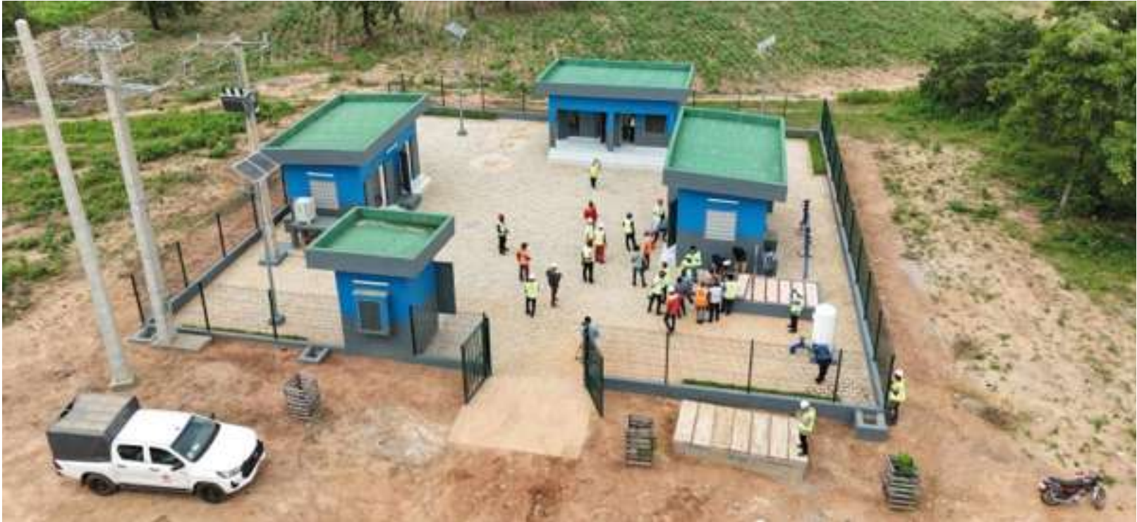
Vue aérienne de la station de pompage et de traitement du SAEPmV de Sontou lors de la réception provisoire du 12 août 2026 par l'ANAEPMR. Le système comprend 4 forages, un château de 250m³ et 71,8 km de réseau pour desservir 6 localités de Pèrèrè
