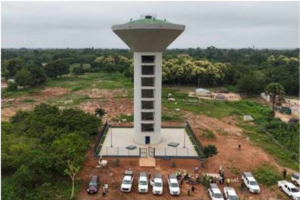
Le château d'eau de 500 m³ à 24 mètres sous cuve du SAEPMV Ouénou 2 à N'Dali, réceptionné par l'ANAEPMR. Avec 6 forages, 110,9 km de réseau et 40 bornes-fontaines, il dessert Ouénou, Ouénou-Peulh et Tamarou
