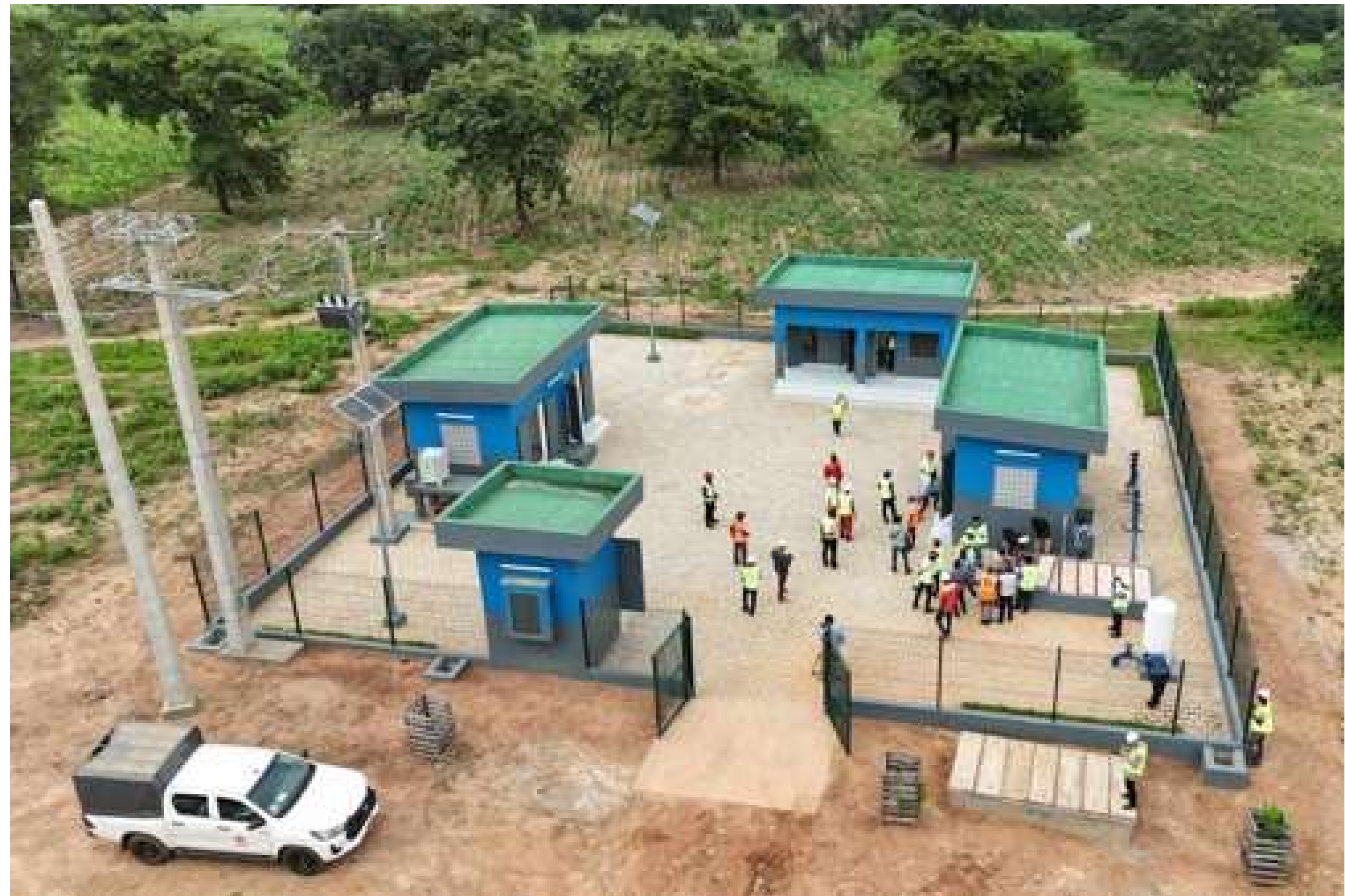
Vue aérienne de la station de pompage du SAEPMV de Pébié à Guinro Centre lors de la réception du 13 août 2026 par l'ANAEPMR. Le système de 27,5 km avec 2 forages et un château de 200 m³ met fin à la consommation d'eaux de marigots pour Guinro, Kpébié, Tchori et Won
