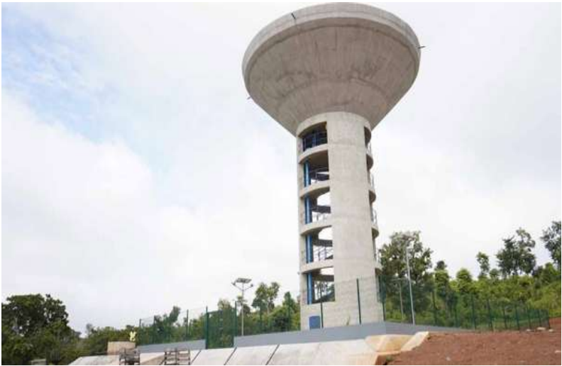
Le château d'eau de 450 m³ à 18 mètres sous cuve du SAEPMV Ouara 2 à Kpétégourou, réceptionné en août 2026 par l'ANAEPMR. Avec 4 forages, 89,8 km de réseau et 25 bornes-fontaines, il dessert Dougu, Soukarou, Ouara et Oura-Peulh.[Ouara][Gogounou]
